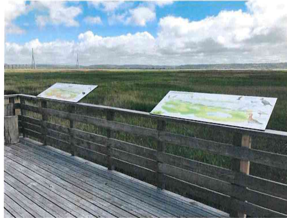
Exemple de table d'orientation de format L1500 x H60cm, en position inclinée, fixée à un garde-corps par le biais d'un support métallique
